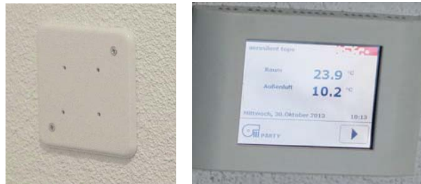
Bild 2 Abdeckung eines Temperaturfühlers (links) und Anzeige der gemessenen Temperatur am Temperaturfühler und der lokalen Aussenlufttemperatur (rechts) (Quelle: IEBau).
