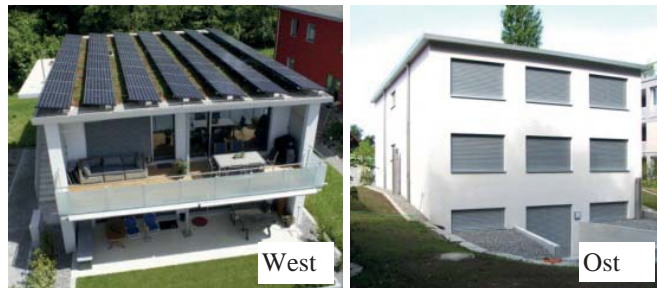
Bild 1 Ansichten des untersuchten Mehrfamilienhauses (Quelle: Setz Architektur, FHNW IEBAU).
