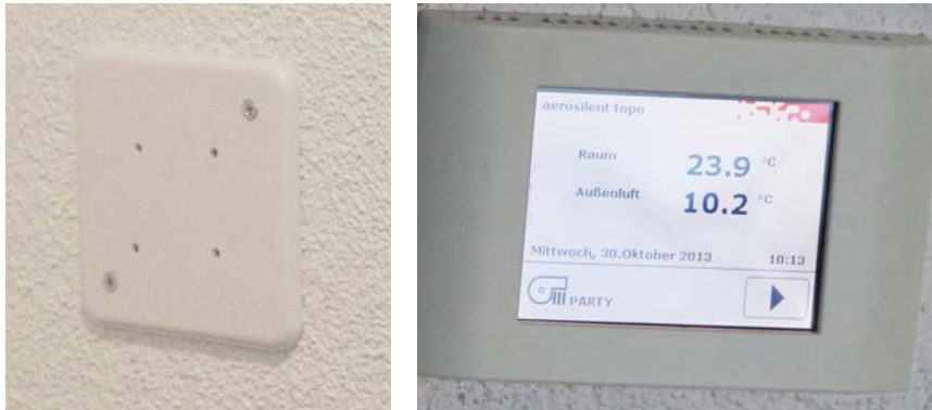
Bild 4: Abdeckung des Temperaturfühlers „OG-Wohnen“ (links) und Anzeige der gemessenen Temperatur am Temperaturfühler und der Außenlufttemperatur an der Klimastation (rechts) (Quelle: IEBau).
