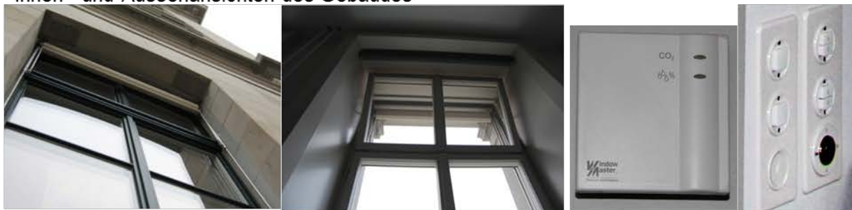
Fenster aussen, geöffnetes Oberlicht, Bedieneinheit, Raumlufttemperatur- und CO 2 Sensor
