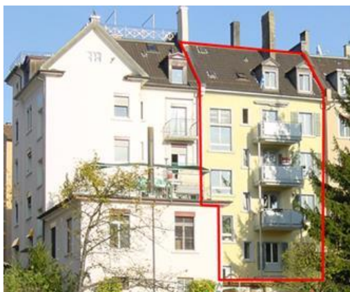
Abbildung 13, Schrittweise erneuertes Mehrfamilienhaus in Zürich
