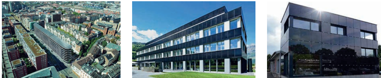
Bild 2. Neubau Aktiv-Stadthaus in Wien (GEB >100 %), Sanierung des Verwaltungsbaus Flumroc, Flums (GEB 115 %), Anbau Bracher+Schaub AG, Ormalingen (GEB 96 %) (Quellen: ABG Frankfurt Holding, Solarpreis [1])
