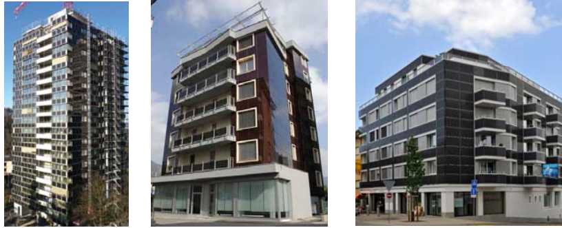
Bild 3: MFH-Sanierung Sihlweidstrasse in Zürich, MFH-Sanierung Palazzo Positivo in Chiasso, MFH-Sanierung in Romanshorn, (Quelle: Internet, Solarpreis [1])
