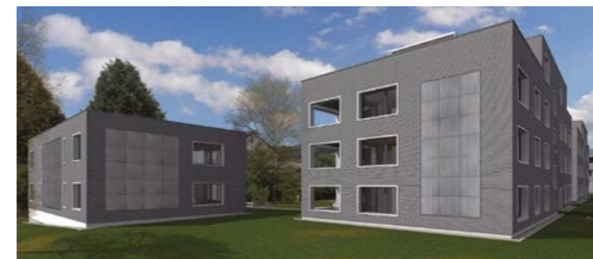
Abbildung 2: PV-Module integriert in die Holzfassade (Quelle: Setz Architektur)
