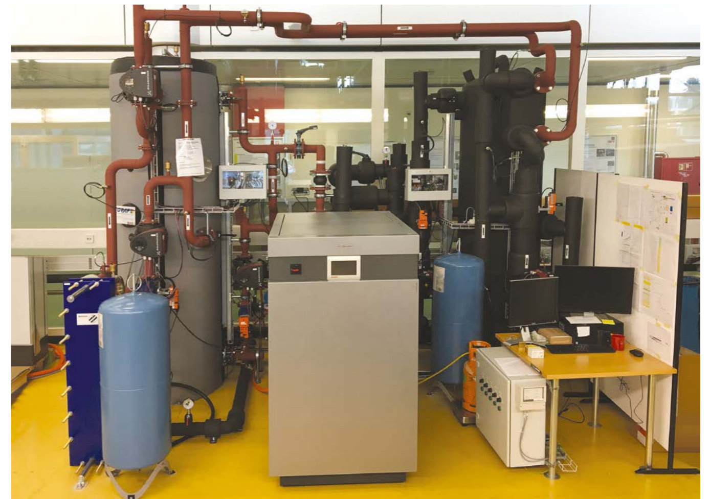
Abbildung 2: Prüfstand im Laborgebäude der FHNW in Brugg-Windisch
