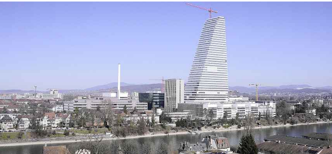
Roche plant in unmittelbarer Nachbarschaft von Bau 1 einen weiteren Turm. Der «Bau 2» wird mit 205 Metern und 50 Stockwerken noch höher sein als «Bau 1». Dieser soll bis 2022 fertig gestellt werden.
