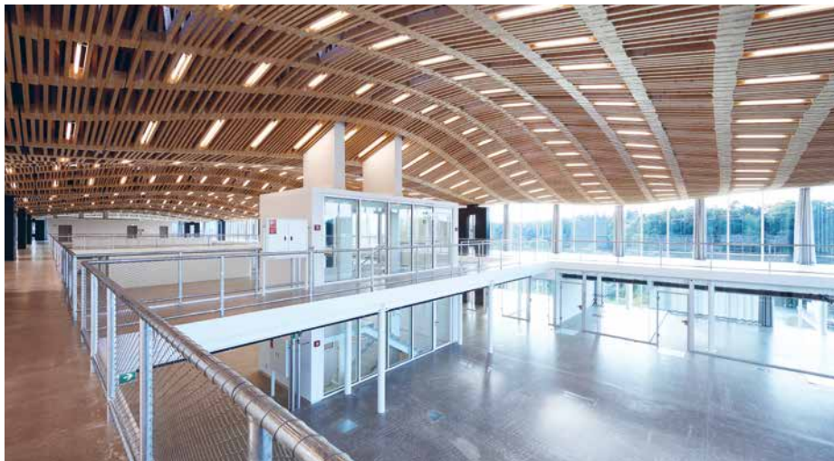
Digital geplant, digital gebaut: Das 2300 m 2 grosse geschwungene Holzdach im neuen Arch_Tec_Lab auf dem ETH-Campus Höggerberg wurde von einem Bauroboter gefertigt. Bild: Andrea Diglas / ITA/Arch-Tec-Lab AG
