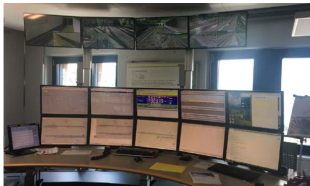
Abbildung 1: Arbeitsplatz eines technischen Operateurs.
