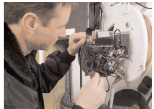
Ein Servicetechniker der Sixmadun AG inspiziert den Brenner einer Kompaktwärmezentrale.
