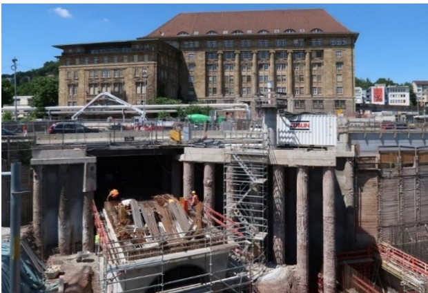
Abbildung 1. Baustelle beim Stuttgarter Hauptbahnhof (Frey, 2017).
