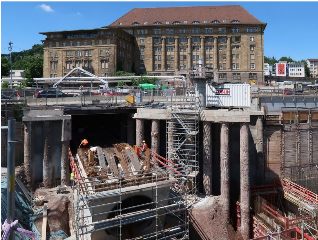
Abbildung 6: Baustelle beim Stuttgarter Hauptbahnhof (Frey, 2017)
