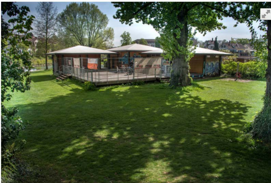
Die Baustelle am Birsköpfli wird bald zur «Veranda Pellicano» (Bild: Alexander Preobrajenski)
