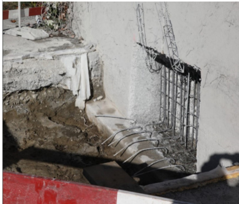
Abbildung 4. Offengelegte Winkelstützmauer. Aus Homepage Talpa-Inspection. Copyright 2024 bei Talpa-Inspection
