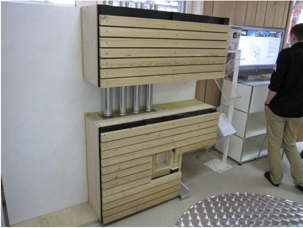
Teilstück eines oberen und unteren F4.1 Basismoduls, Situation am Bau vor dem Aufsetzen des oberen Moduls
