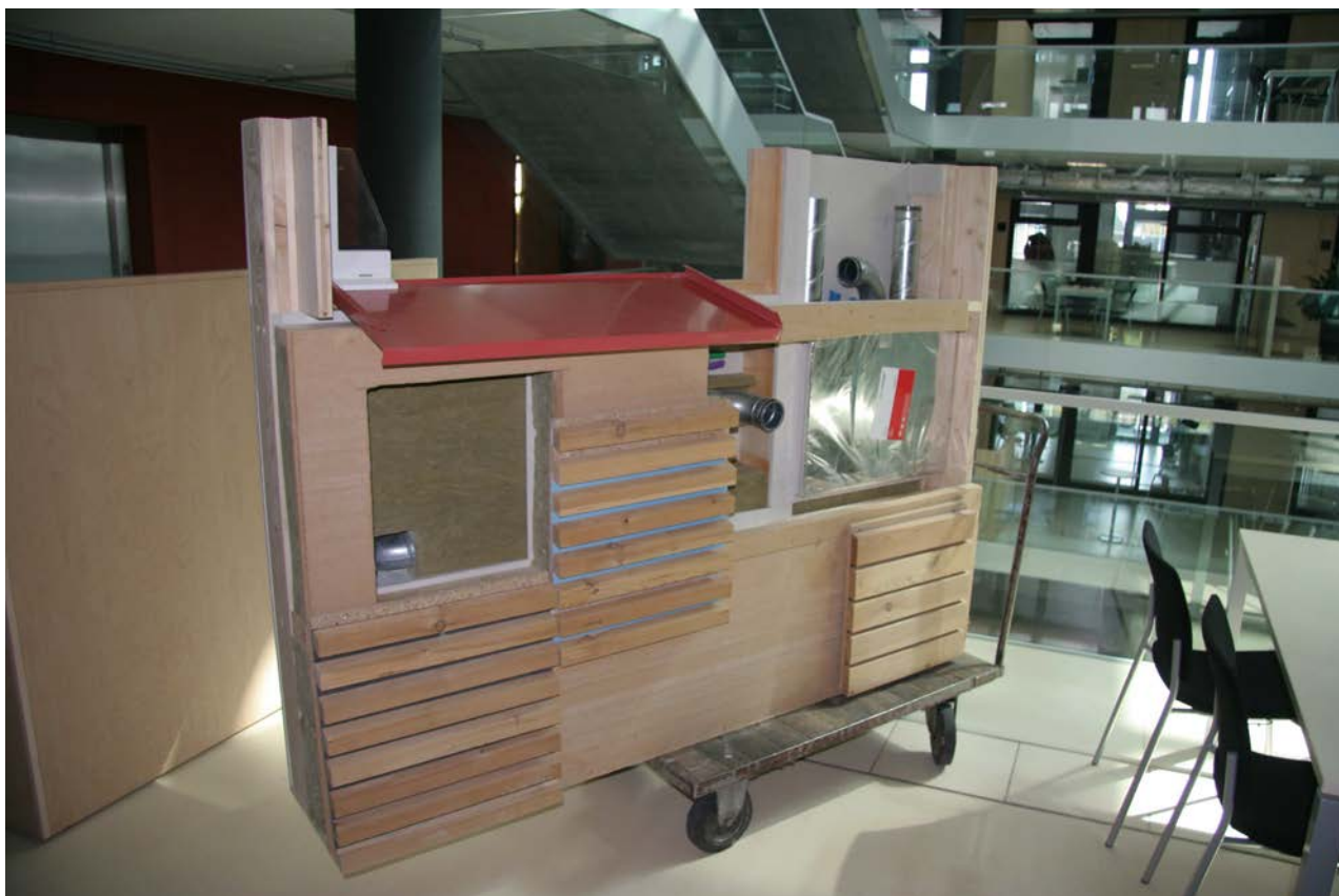
Abbildung 77: Unterer Teil eines ersten Arbeitsmodells zur Beobachtung der Arbeitabläufe im Werk, erstellt durch Firma Bächli Holzbau AG
