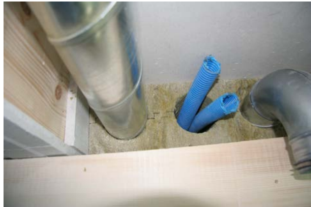
Abbildung 18: Einblick in das Innenleben, Lüftungsrohre mit Flumroc Halbschalen in einen Arbeitsmodell, erstellt durch Bächli Holzbau AG, Embrach
