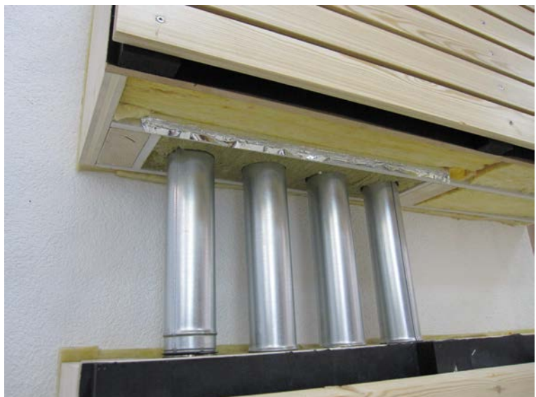
Abbildung 21: F4.1 Modul, mit eingesteckten Lüftungsleitungen
