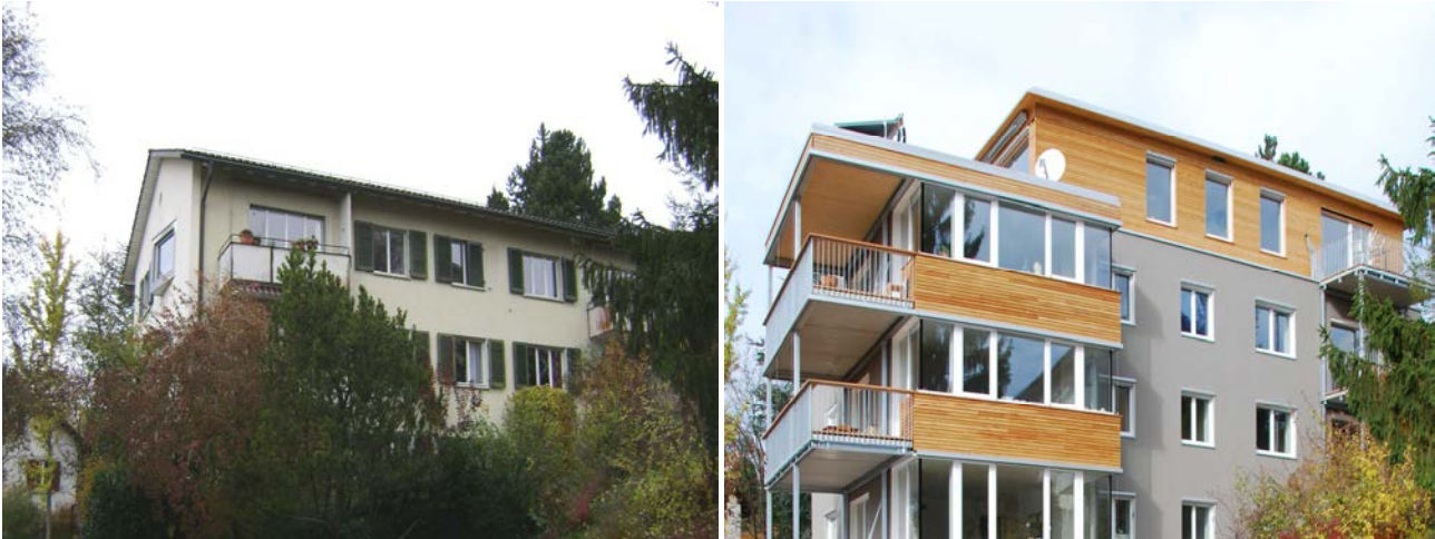
Abbildung 79: Wohnbauerneuerung eines MFH vorher und nachher. Architekt und Foto: Kämpfen für Architektur, Zürich
