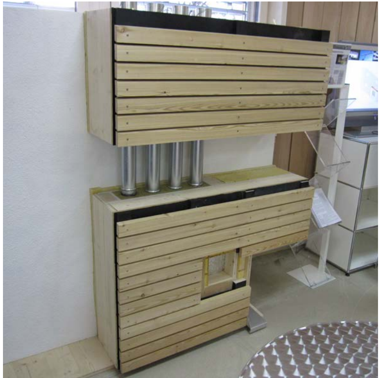
Abbildung 20: Modell an der SWISSBAU 2010, Die Fassade wurde hier als hinterlüftete Holzfassade ausgeführt (erstellt durch Firma Bächli Holzbau) .
