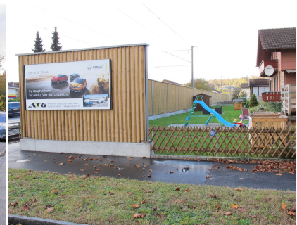
c | Lärmschutzwand entlang Gränicherstrasse
