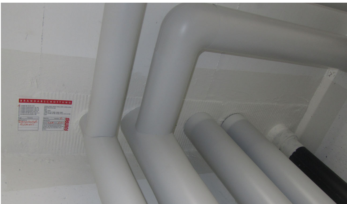
Bild 5 Luftdichte Ausführung der Brandschutzabschottung für Wasserrohre in der Geschosdecke.
