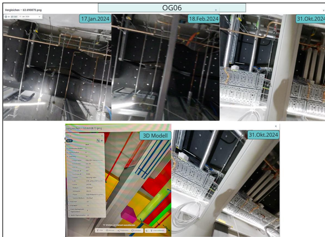
Abbildung 22: Baufortschritte im OG06 mittels SiteWalks
