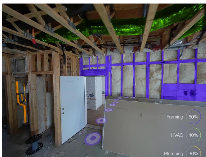
Abbildung 10: KI-Umsetzung zur Verfolgung des Baufortschritts. Quelle: OnsiteIQ, 2024
