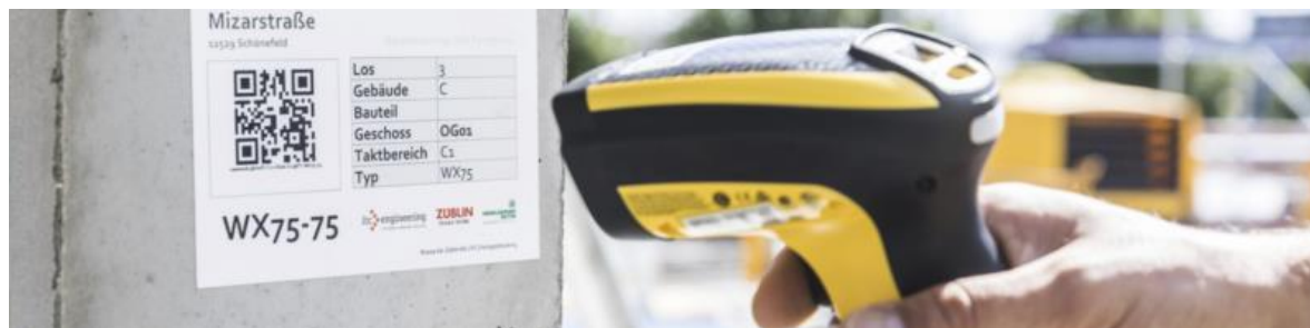
Abb. 38 Bauteiltracking mittels QR-Code (Strabag, 2023)
