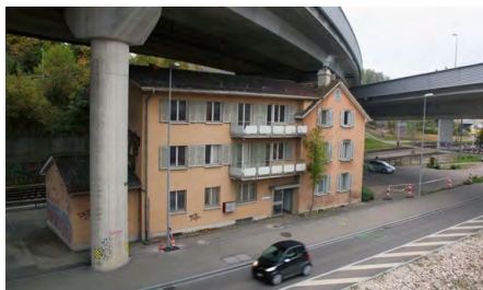
Abb. 2: Ehemaliges Haus unter dem Autobahnkreuz an der Zürcher Allmendstrasse 77 (Hämmerle, 2012).
