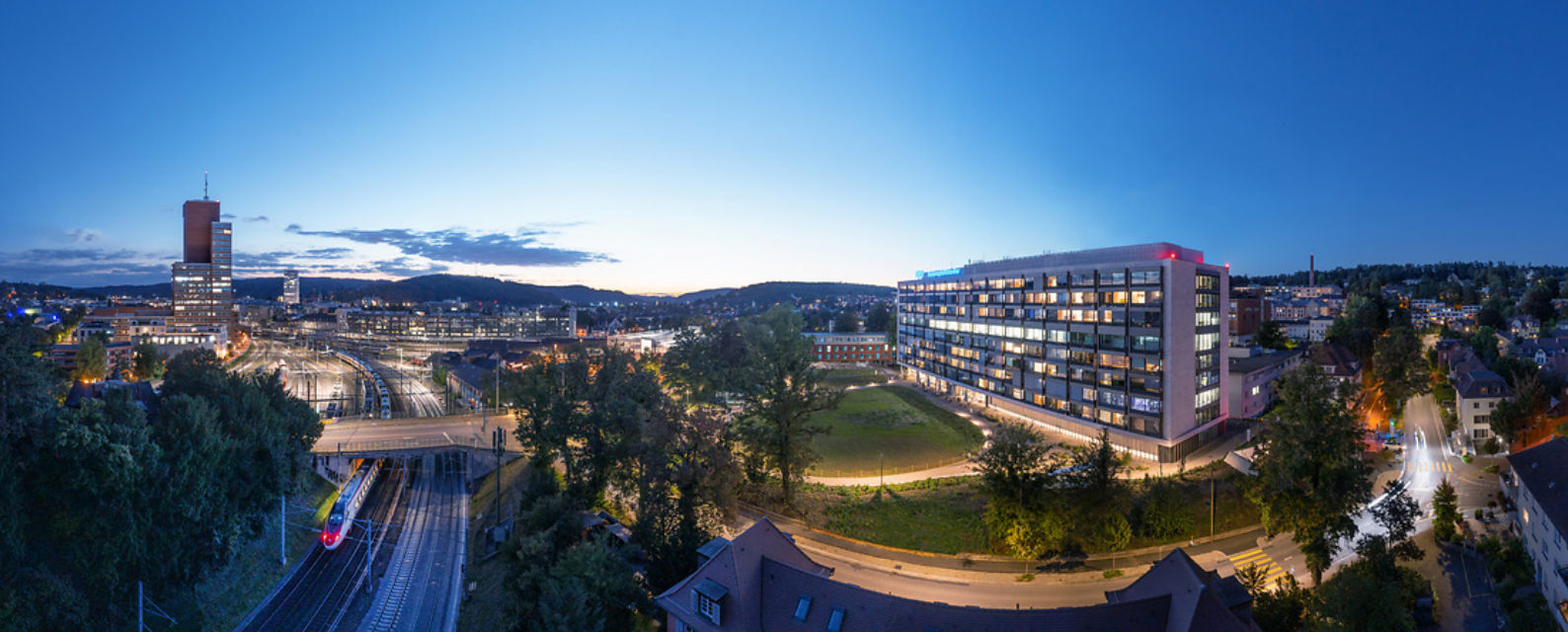
Hôpital cantonal de Winterthour
