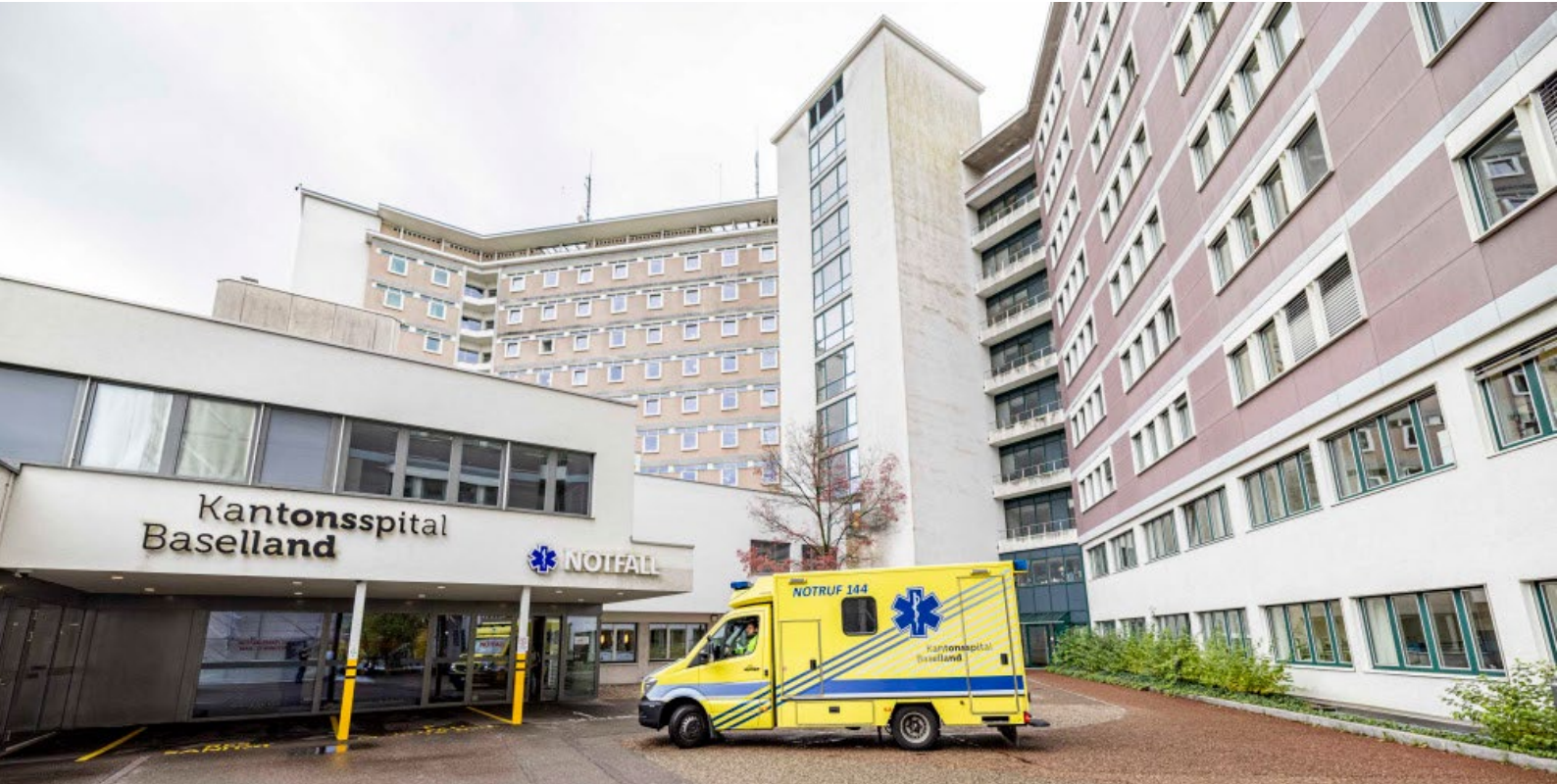
Hôpital cantonal de Bâle-Campagne
