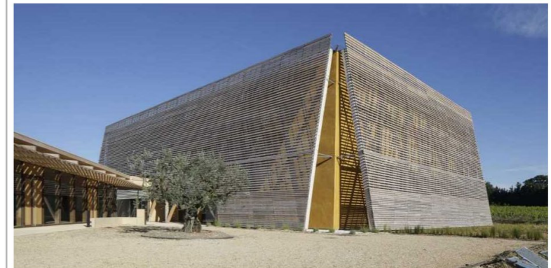
Eine mit Strohballen isolierte Holzkonstruktion, die Platz für 1000 Personen bietet: Das Kulturzentrum in Mazan, Frankreich, von De-So Architects und Gaujard Technologie. (Bild: Hervé Abbadie / DE-SO Architects)
