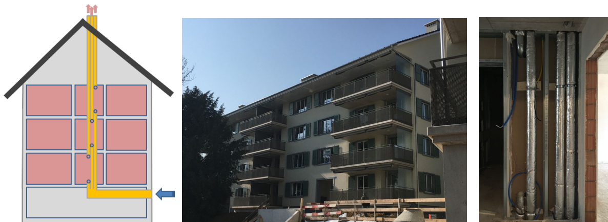
Bild 2 Links: Prinzipskizze der «Kölner» Lüftung, angewendet auf die Belüftung der innenliegenden Bäder/WC. Mitte: Mehrfamilienhaus mit Monitoring der Schwerkraftlüftung in den innenliegenden Bädern, Neubau Bezug 2022 (© INEB). Rechts: Lüftungsrohre im Erdgeschoss für die Schwerkraftlüftung (© Ferrara Architekten). Jedes innenliegende Bad ist mit einem eigenen Rohrstrang versehen.
