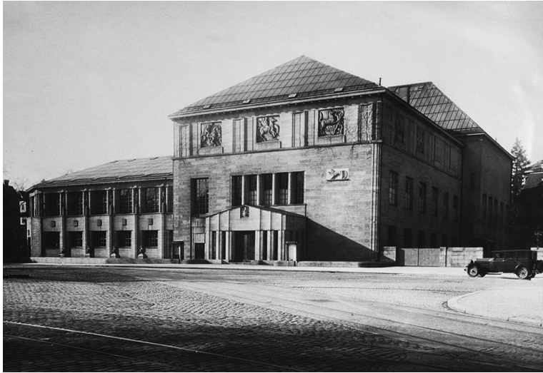
26 (oben) Curjel & Moser: Erweiterung Kunsthaus Zürich 1907–1910 (gta Archiv, ETH Zürich: Nachlass Karl Moser, Foto 1910: Philipp & Ernst Linck)
