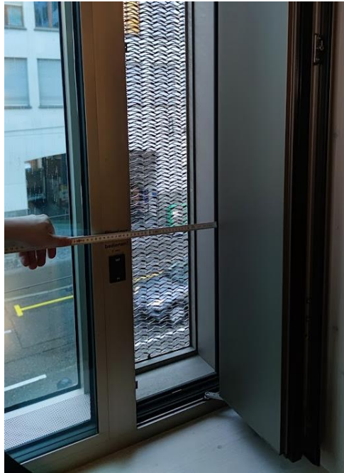
Abbildung 11. Automatisierte Aussenklappe im Objekt «AUE BS» zum Luftwechsel bzw. als Nachströmöffnung für die Nachtauskühlung
