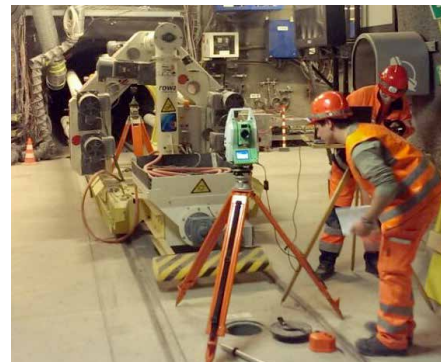
Abb. 10: Überwachung der Messungen mit TM30 – im Hintergrund die Betonit-Hinterfüllmaschine für die Einlagerung der simulierten atomaren Abfallbehälter.
