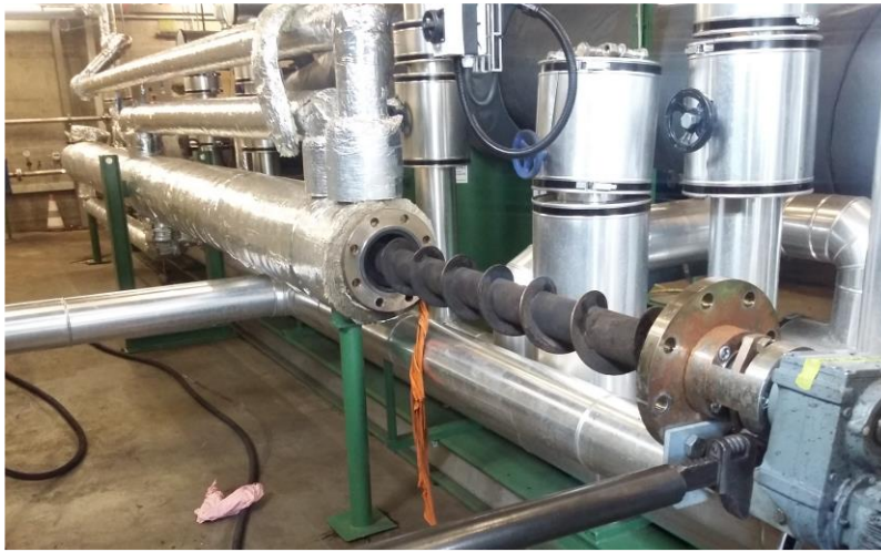
Abbildung 4: Neue beheizbare Förderschnecke [18]
