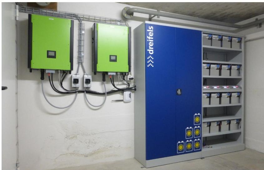
Abbildung 13: Batteriespeicher im UG des Kohlesilos, Quelle: Dreifels, Gelterkinden
